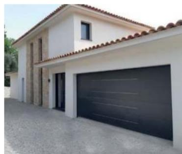
La porte de garage sectionnelle est composée de panneaux assemblés à l'horizontale.
