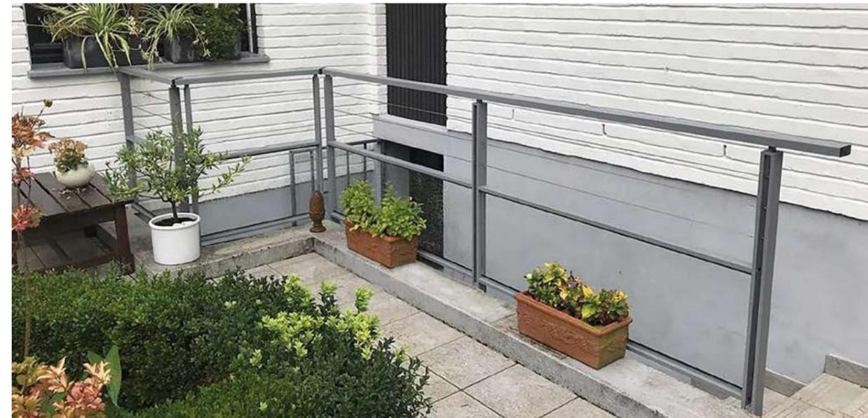
Avec câbles et remplissage. Vitrage transparent. Pose sur dalle. *RAL 7016.*
