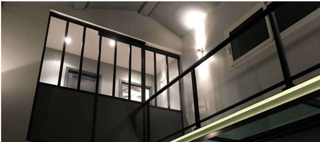
Remplissage sous main courante. Vitrage bronze. Pose sur dalle. *RAL 9005.*
