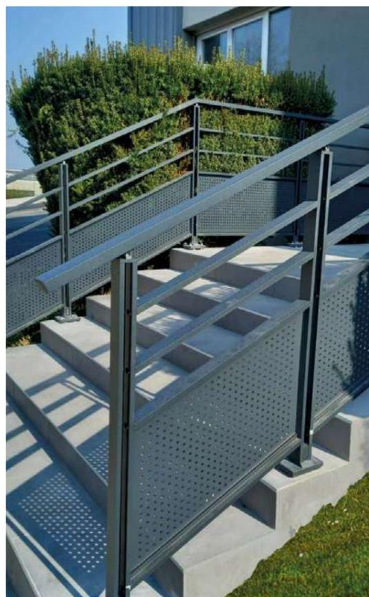
Lisses avec remplissage en soubassement.
