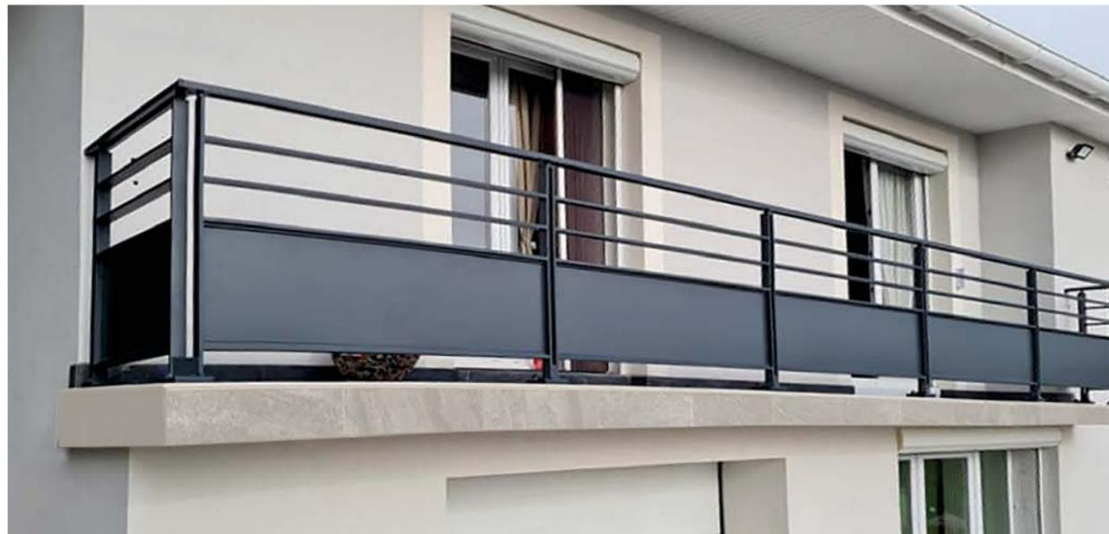
Lisses avec remplissage en soubassement.
