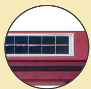
Capteur solaire intégré
