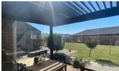
La Pergola Bioclimatique est une structure en aluminium composée de **lames orientables motorisées**.
